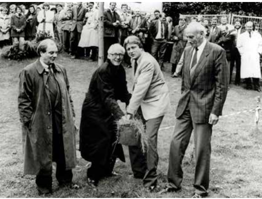
Der erste Spatenstich für die DBU-Geschäftsstelle im Jahr 1993
